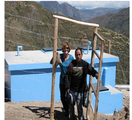
Claire et le contremaître Elio devant le réservoir principal
