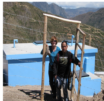
Claire et le contremaître Elio devant le réservoir principal
