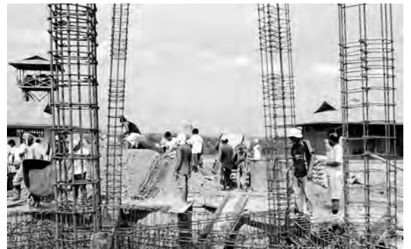
La base du réservoir en construction
