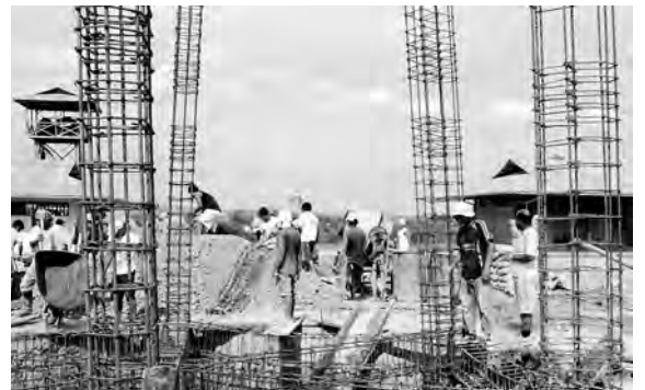
La base du réservoir en construction
