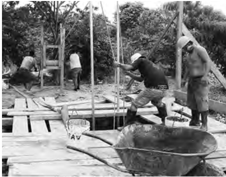
Le creusage du puits se fait totalement à main d'homme
