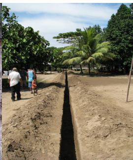
La tranchée à Montevideo
