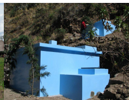
Deux réservoirs du projet d'eau de Parcco
