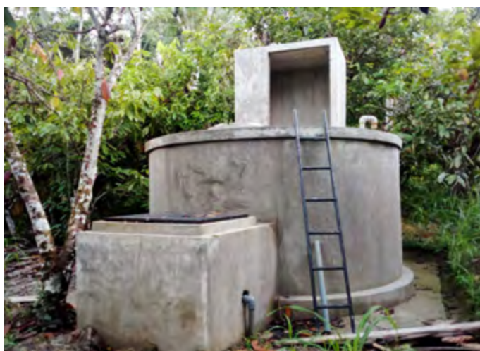
Le réservoir de Canuja sera peint dès l'arrêt des pluies
