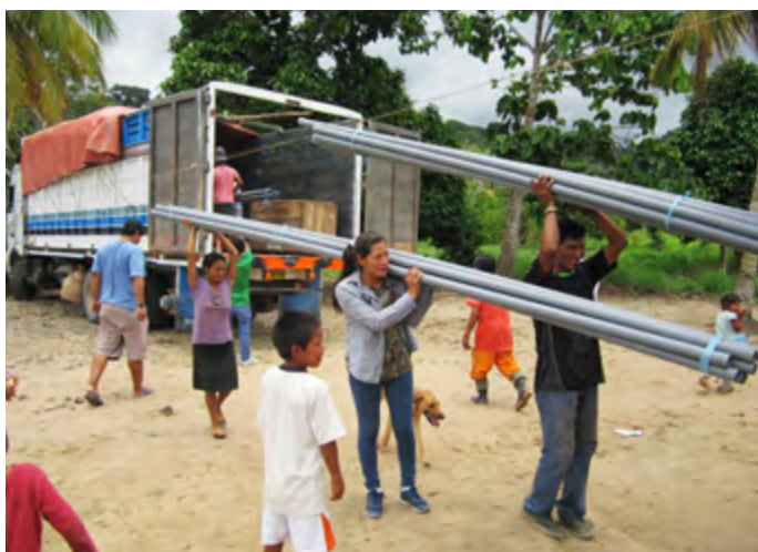
L'arrivée des tuyaux, un moment fort, rempli de joie!
