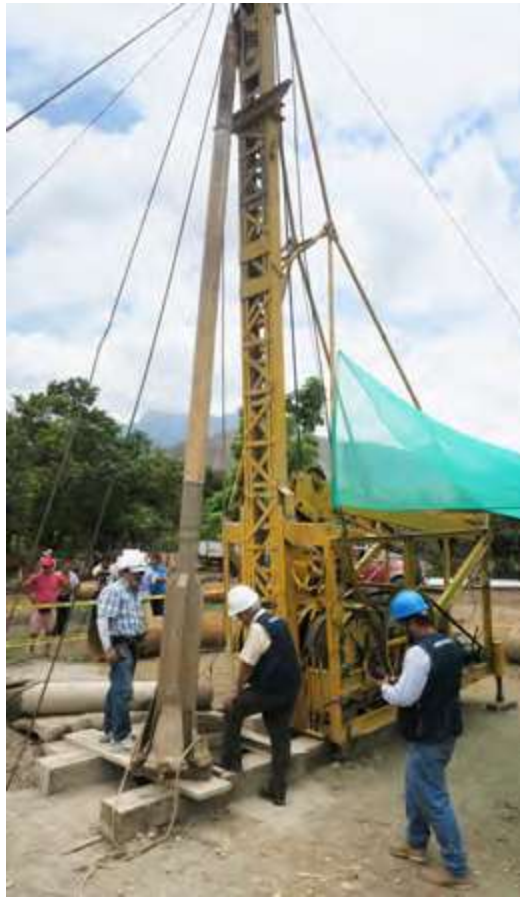
Le forage du puits à La Ramada
