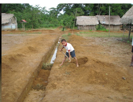
Shirintiari, un jeune remplit des tranchées
