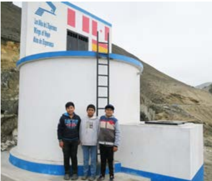
Le réservoir de Rio Seco surmonté de la caseta de chloration
