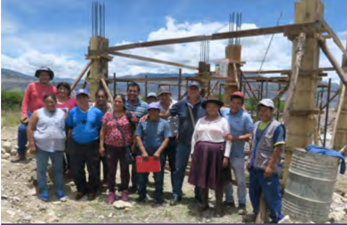
L'ingénieur William et des habitants d'Azángaro devant le réservoir en construction
