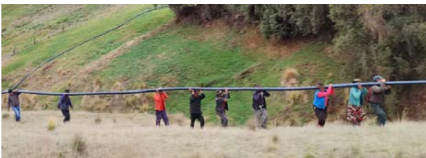
À Putacca, les villageois transportent le long tuyau de 50 m
