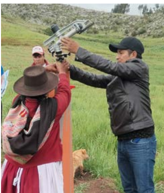
Installation du dernier hydrante (aspersoir) à Putacca. Ce système d'irrigation réalisé en partenariat avec la Municipalité provinciale de Vilcashuamán couvre 60 hectares
