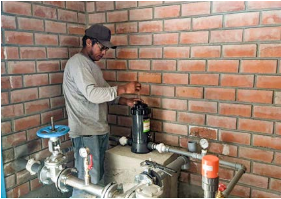
Venturosa : le maestro Llutari fait la mise au point du système de chloration de l'eau
