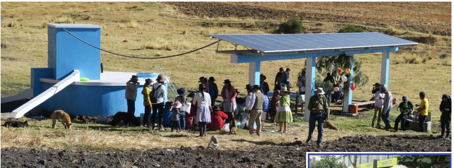
Citerne et panneaux solaires à Wallpapacana
