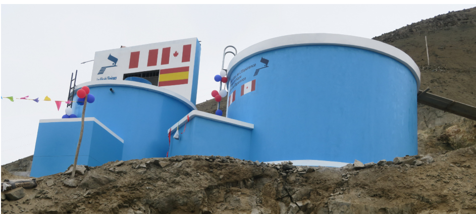
Le 23 août, nous avons inauguré à Rio Seco le second réservoir (à droite)
