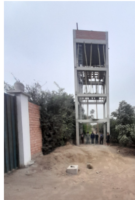
Les panneaux solaires et le réservoir
