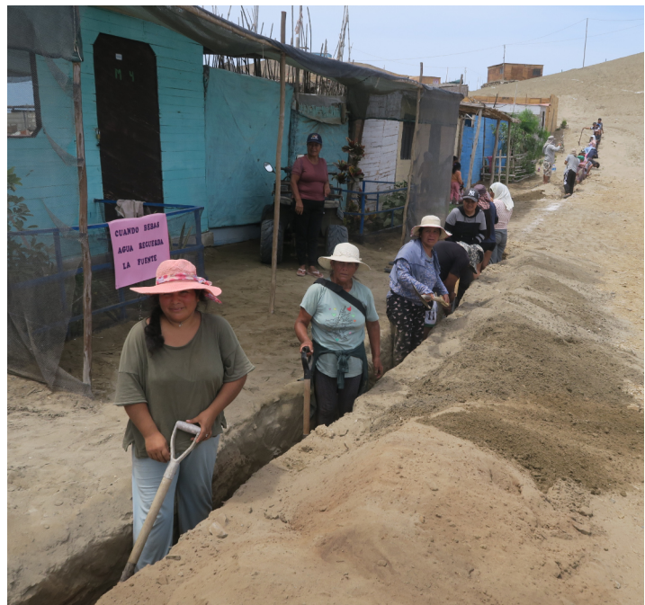
The women happily participate in digging the trench on 21 de Septiembre
